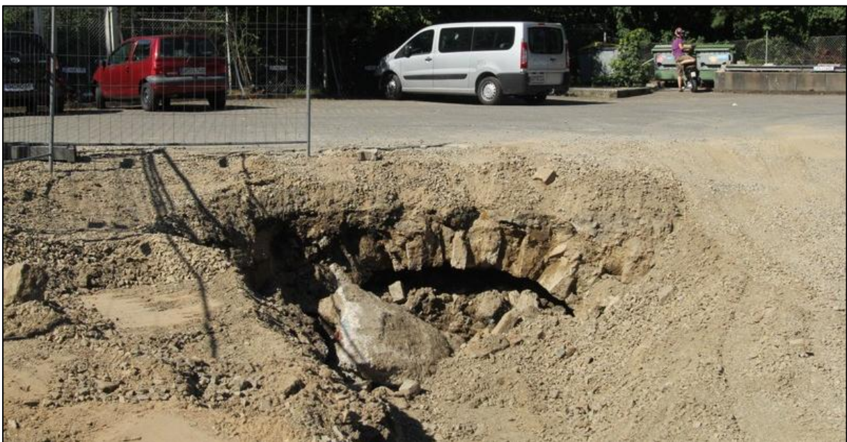
Blick nach Norden: Gewölbe des Untergrabens, September 2013 (Aufnahme: Daniel Rutz)
